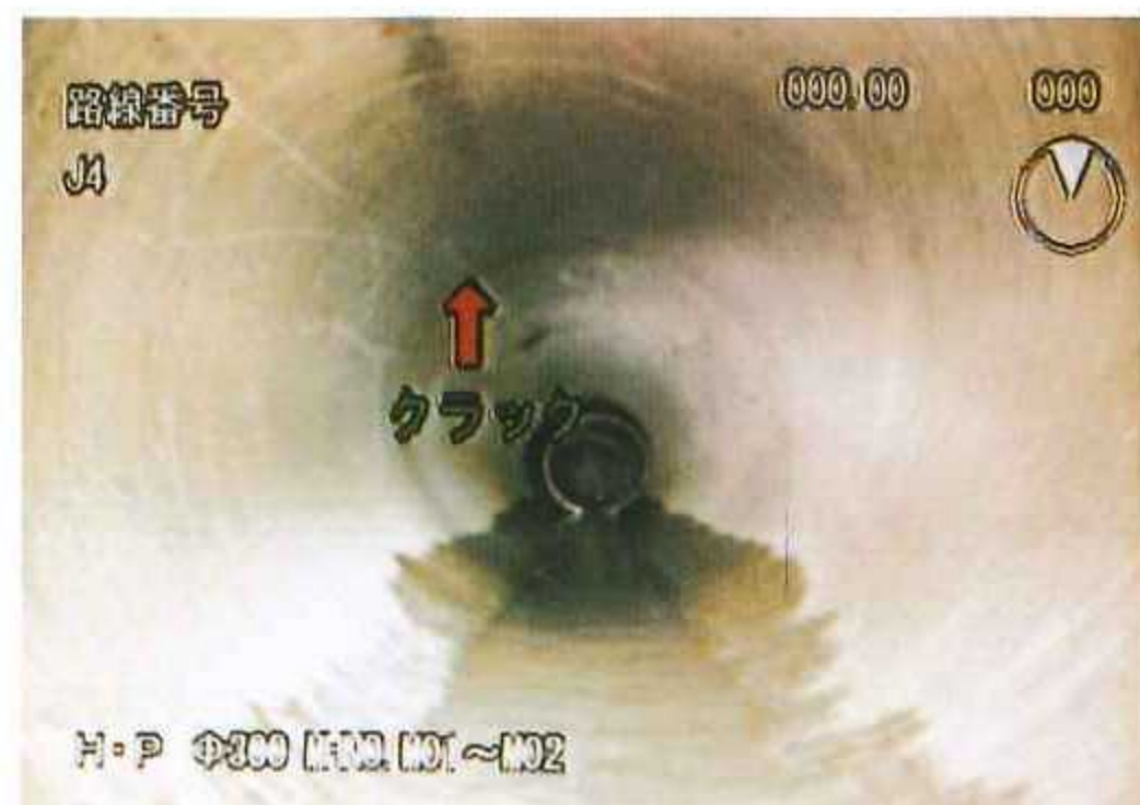
撮影した管内写真
